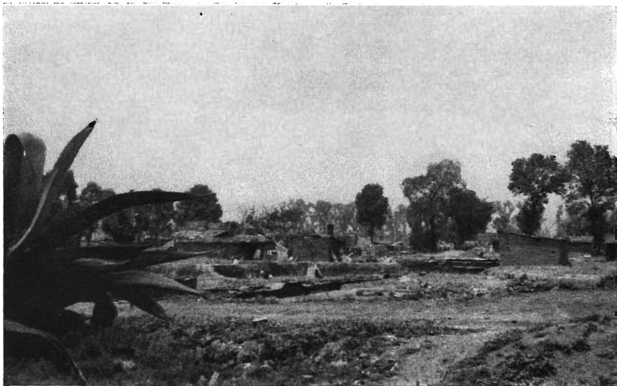
En los alrededores del fraccionamiento de San Mateo, algunas viviendas típicas en donde se observan excavaciones en el terreno para utilizar la arcilla en la fabricación de ladrillos
