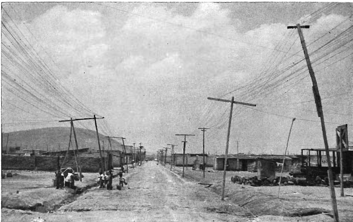
Fraccionamiento proletario La Aurora, cerca de Los Reyes. Aspecto que representan las instalaciones eléctricas
