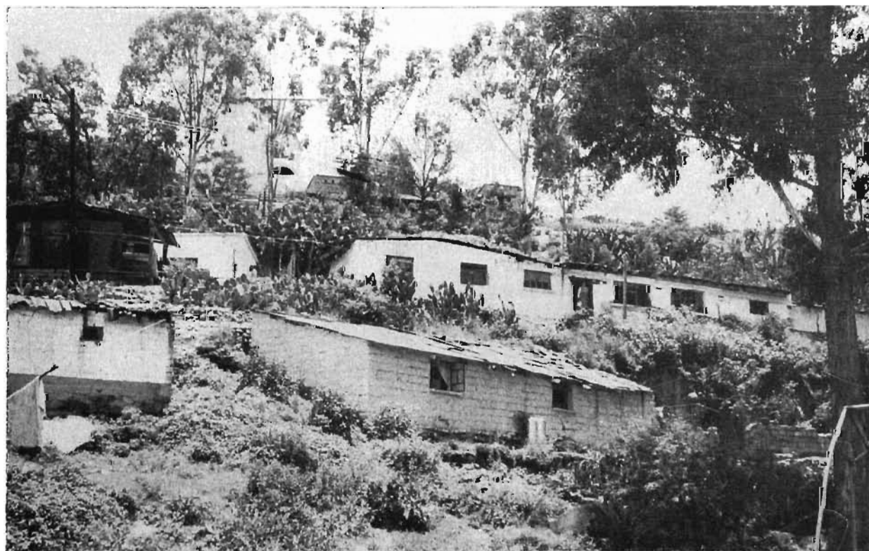
Casa habitación en el poblado La Colmena, municipio de Villa Nicolás Romero Estado de México. Las paredes hechas de tabicones y los techos de lámina o cartón
