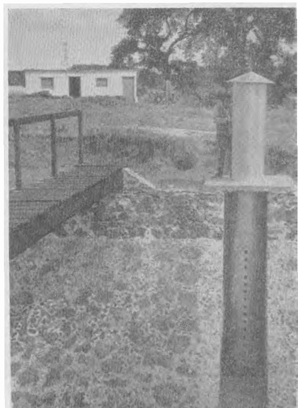
14. Estación hidrométrica Potrerito. Localizada en la confluencia de los ríos Barranca del Monte y Tizar. Fotografía tomada desde la margen derecha del Río Barranca del Monte. En primer plano se aprecia el limnógrafo y al fondo la casa del aforador. En esta estación se registran los escurrimientos totales producidos en la subcuenca del Río Barranca del Monte.
