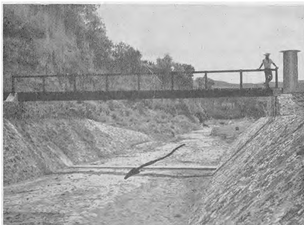
18. Estación hidrométrica San Marcos. Vista desde aguas abajo del Río Tizar. Se aprecia el puente para aforar y el limnógrafo. Esta estación registra los escurrimientos totales de la subcuenca de los ríos Batranca de Tenexcalco y Barranca del Tizar.
