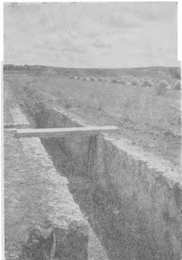
13. Canal El Jagüey, estación hidrométrica. Al fondo el jagüey de Malpaís, corresponde al poblado de Cuauila. Esta estación registra los escurrimientos derivados del Río Barranca del Monte a El Jagüey antes mencionado.
