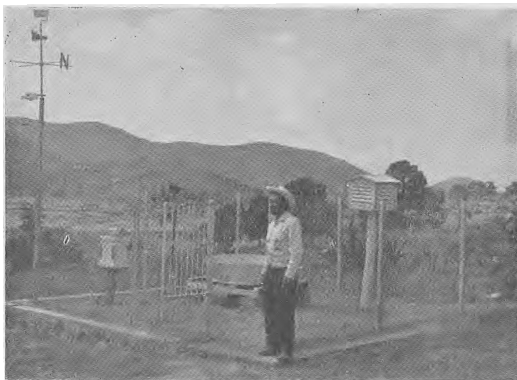
9. Estación climatológica San José. Se encuentra localizada aproximadamente a una distancia de 200 m. del parteaguas sureste de la subcuenca del Río Barranca del Monte. Distribución general de los aparatos.
