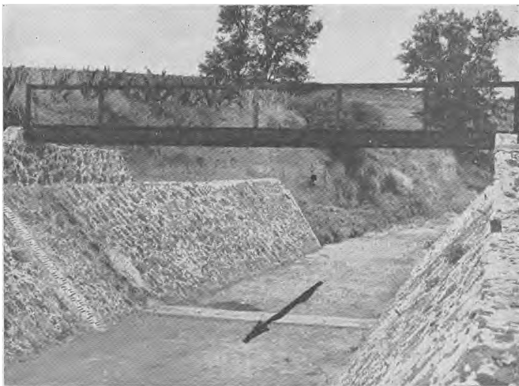
15. Estación hidrométrica Potrerito. Vista desde aguas abajo. En primer término el puente de aforo, a la izquierda la escala de cemento.
